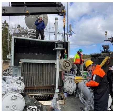
Generatoren lyfts in igen med hjälp av A213 Nordanö
